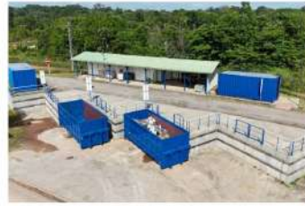
Vue d'ensemble de la déchèterie Colibri à l'écopôle de Saint-Laurent-du-Maroni. Une zone pour accueillir les divers types de déchets des particuliers. - ©Elys LECOQ
