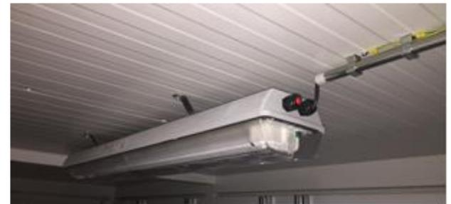
Certificat ATEX du luminaire fourni à la commande avec le dossier technique.
