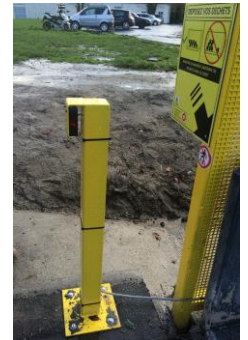
• Barrière immatérielle de sécurité
