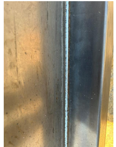
Soudures continues faites au robot
