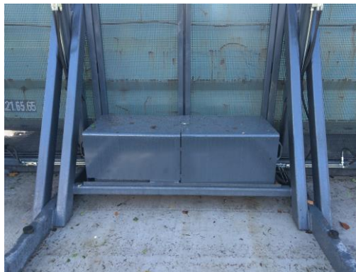
• Centrale hydraulique cartésiée
