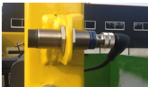
• DéTECTEURS de portes ouvertes du local maintenance
