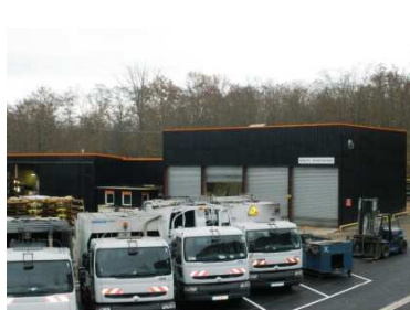
Atelier de Maintenance
