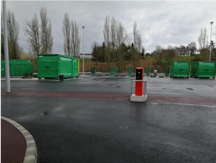
Les travaux se terminent à la déchetterie de Caligny qui devrait rouvrir avant la fin du mois d'avril 2019. (©L'Orne Combattante)
