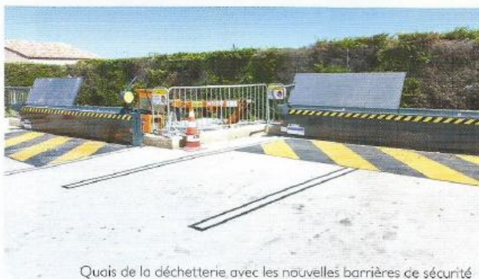
Quais de la déchetterie, avec les nouvelles barrières de sécurité
